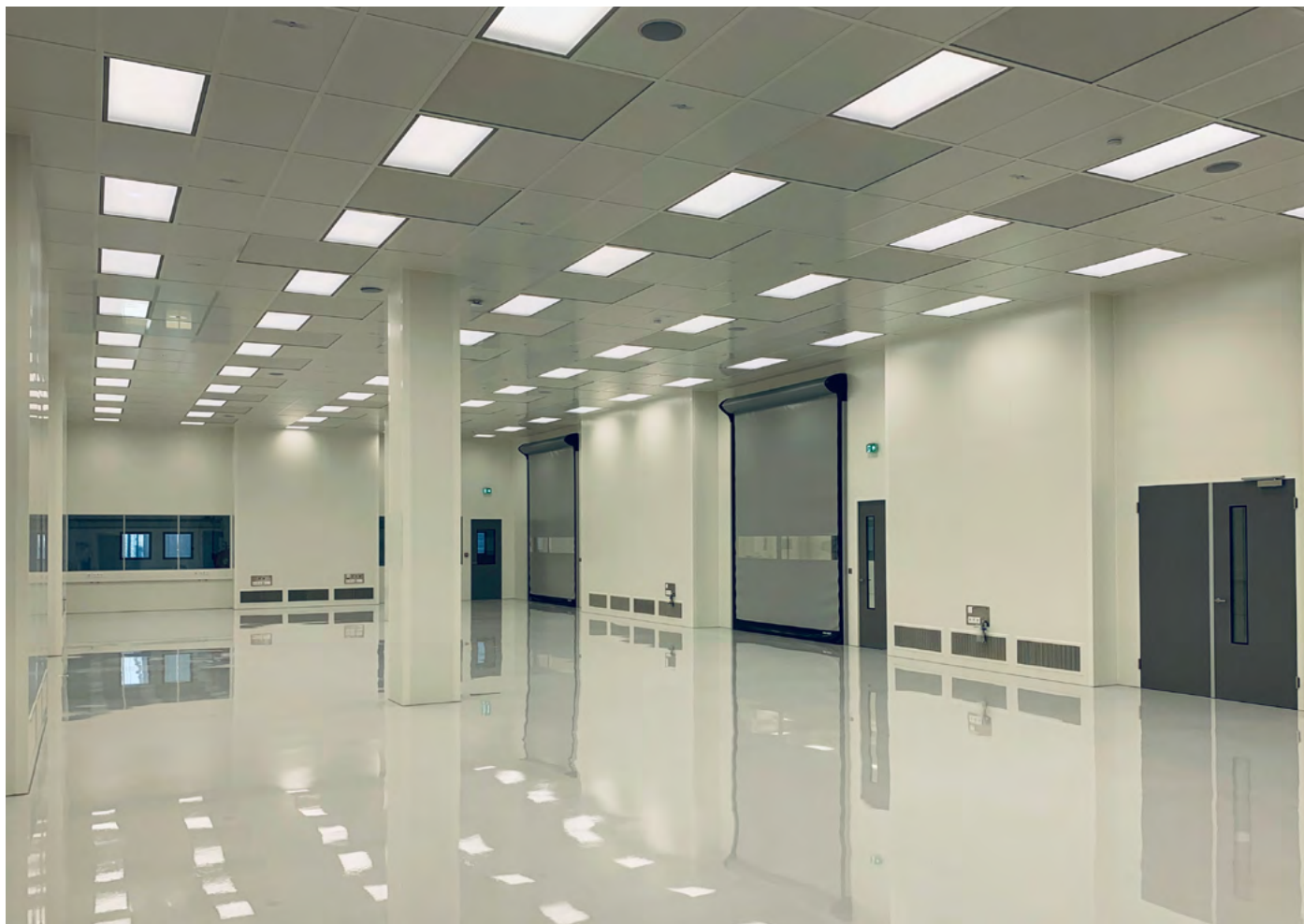
Obszar produkcyjny modułów mechanicznych, Cleanroom, Eindhoven. Holandia 81
