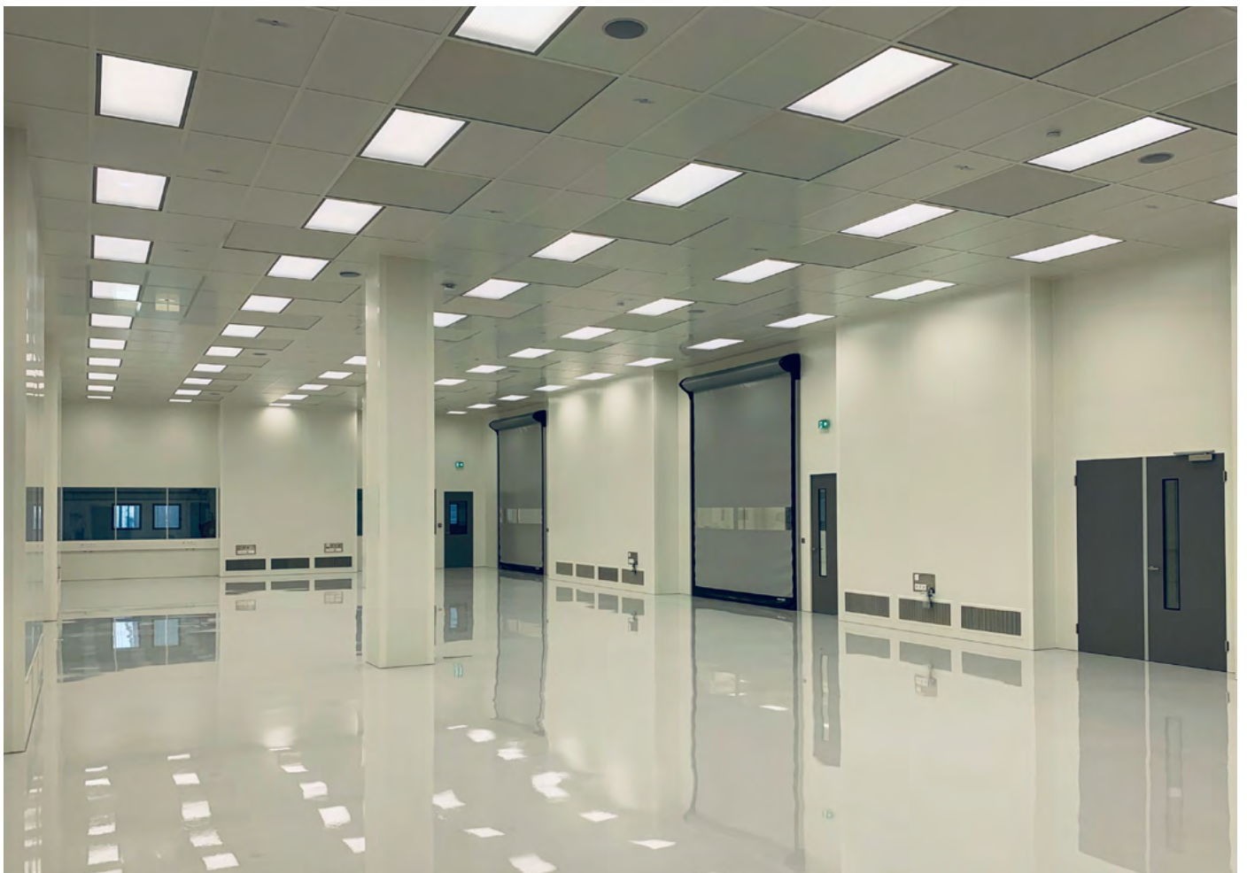
Zone de production de modules mécaniques, Salle blanche, Eindhoven. Pays-Bas 81
